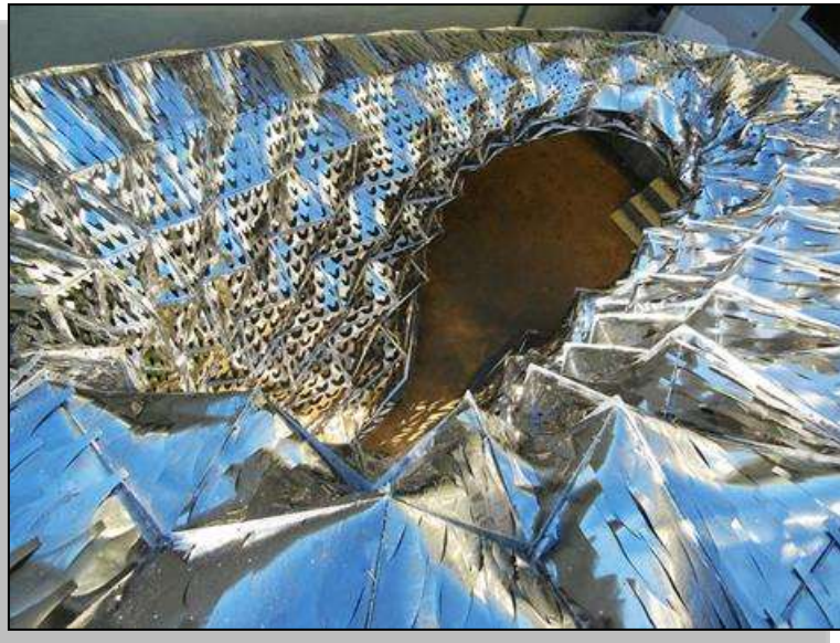
صورة توضح شكل عام للهيكل المعدني وهو مغلق اثناء النهار وارتفاع درجة الحرارة
