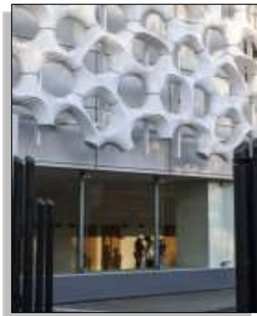
صور توضح شكل الوحدة التكرارية (الخلية) المصمم منها الشبكة المنقية للهواء على واجهة المستشفى ، وطرق تكرارها وتراصها
