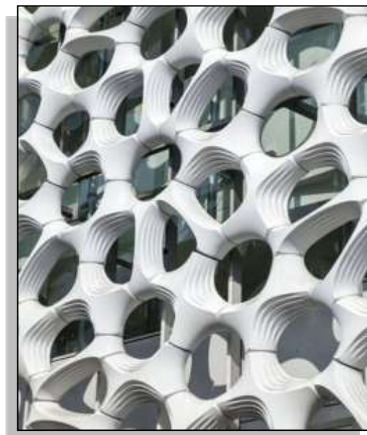
صور توضح شكل الوحدة التكرارية (الخلية) المصمم منها الشبكة المنقية للهواء على واجهة المستشفى ، وطرق تكرارها وتراصها
